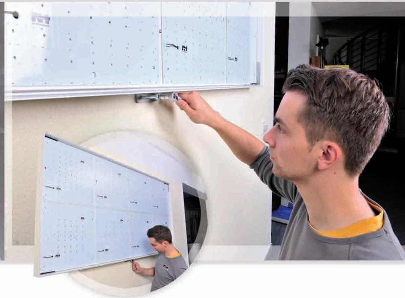
6. Nach der Verschraubung der unteren Laschen lässt sich der Rahmen nicht mehr von der Wand heben und ist somit gesichert.
