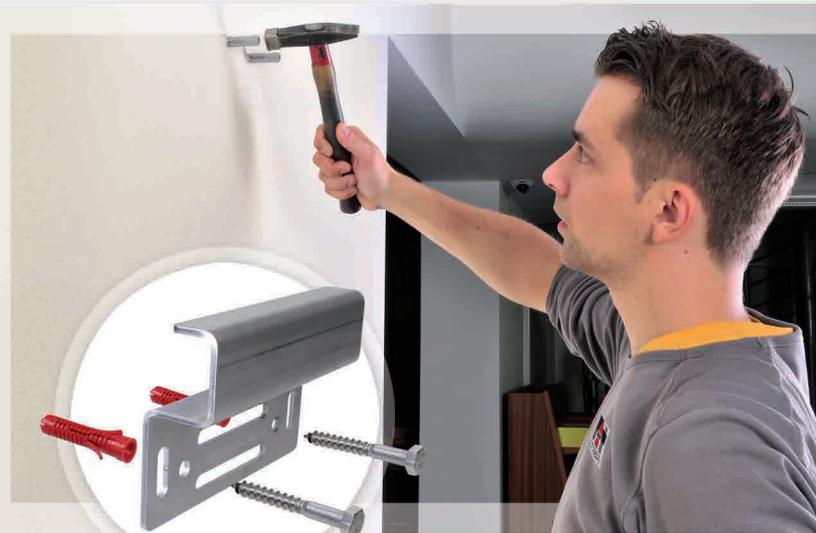
1. Im ersten Arbeitsschritt werden die Bohrungen für die Aufhängungen gesetzt. Hierbei können die Aufhängungsglaschen nach der gewünschten Positionierung als Bohrschablone genutzt werden.
