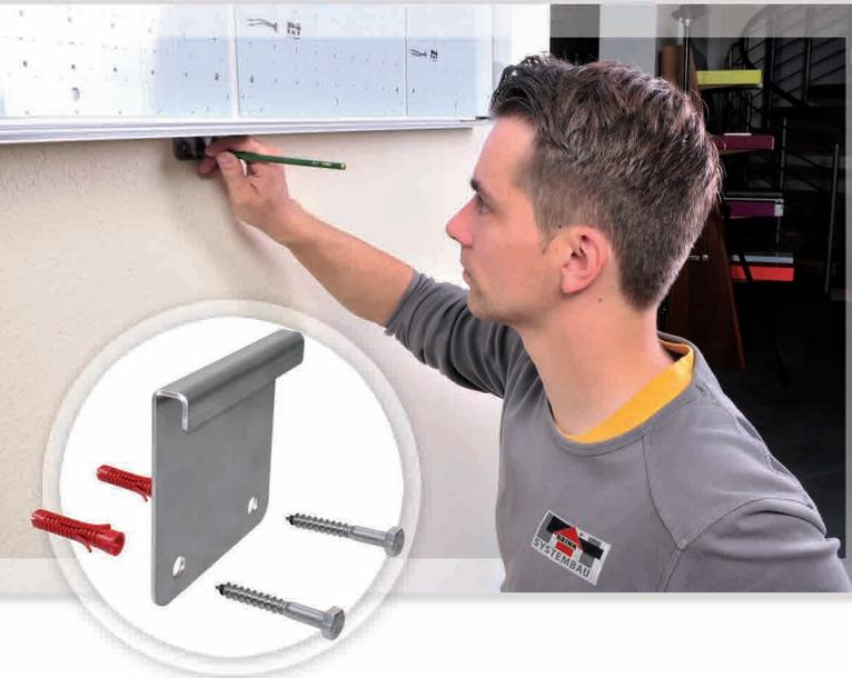
5. Nach der Anbringung der Rahmenkonstruktion an den oberen Aufhängungen, werden die Bohrungspunkte für die unteren Aufhängelaschen positioniert und danach gebohrt. Auch hier können die unteren Laschen als Schablone für das Anzeichnen verwendet werden.
