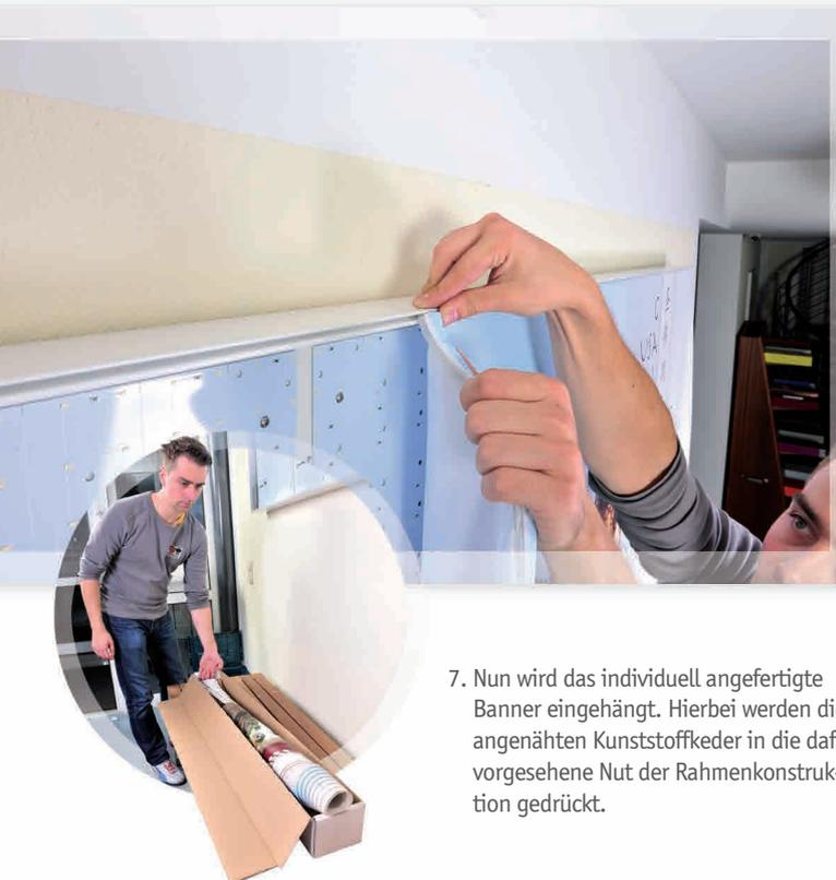
7. Nun wird das individuell angefertigte Banner eingehängt. Hierbei werden die angenähten Kunststoffkeder in die dafür vorgesehene Nut der Rahmenkonstruktion gedrückt.
